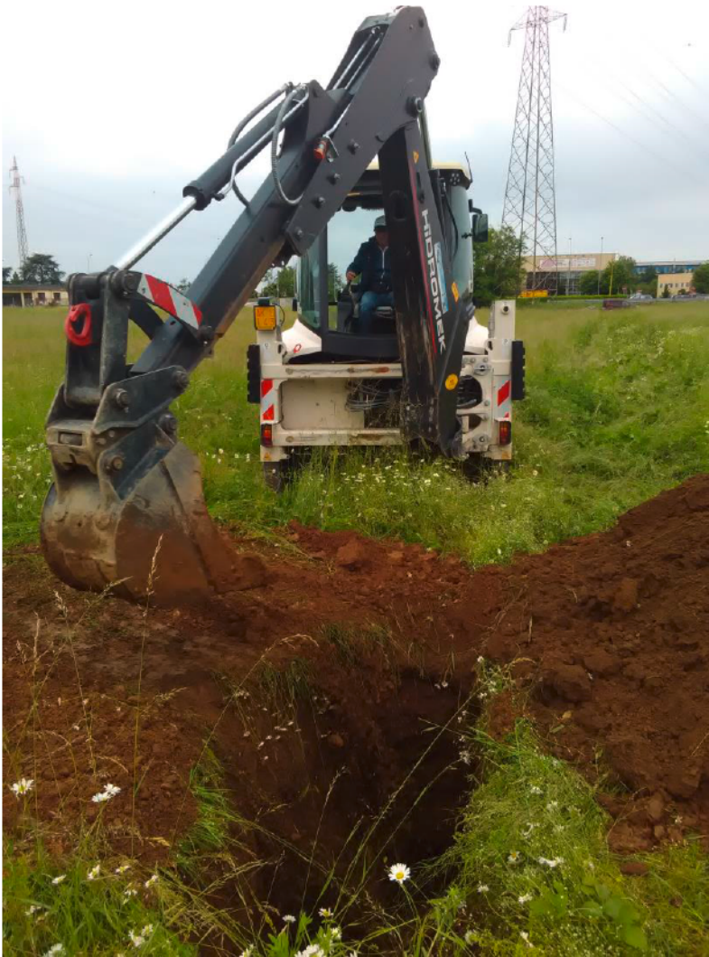
Foto 1: esecuzione scavo SC1
